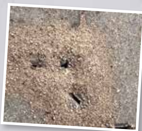
budováním podzemních mravenišť ničí podloží dlažby
